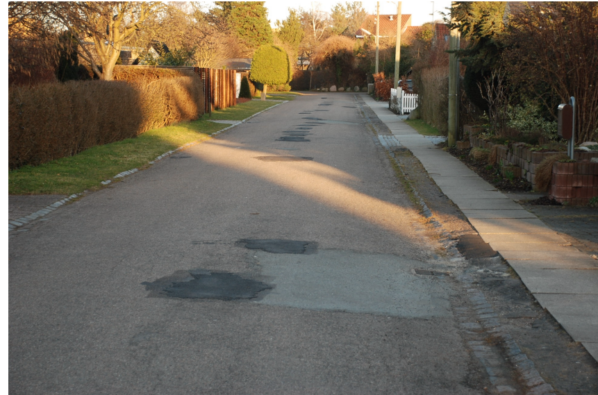
Pileengen før udlægning af overfladebelægning på vejbanen og ændring af fortov til græsabat 2014. Foto Søren Svendsen
